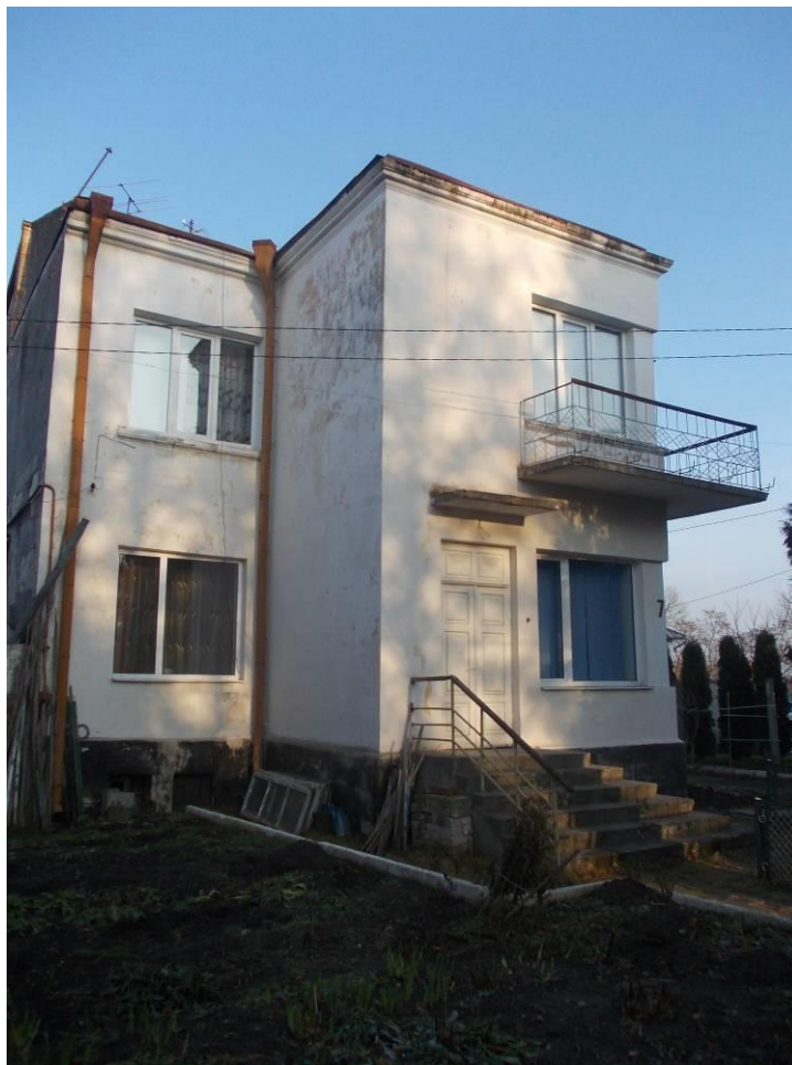
Фото 3.13. Житловий будинок, 20-30-і рр. XX ст., вул. Замкова, 7
