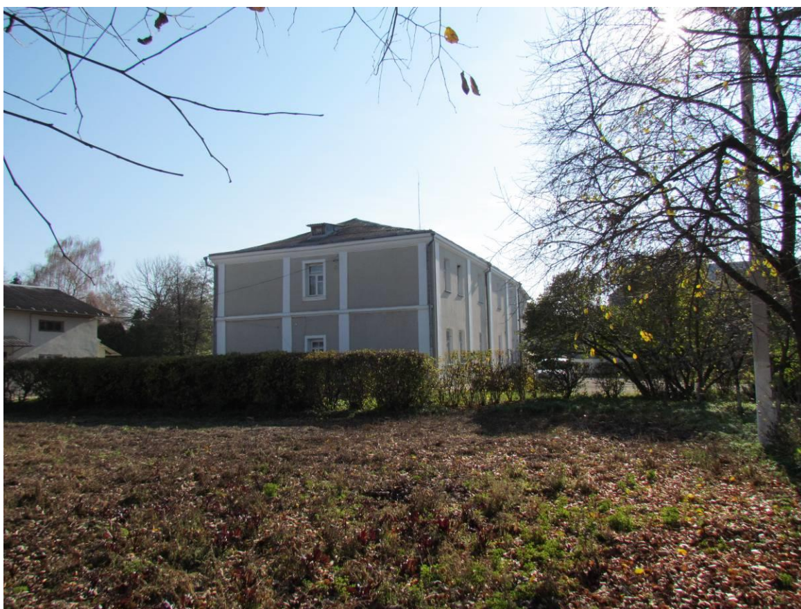
Фото 2.5. Колишня лікарня, XIX ст., вул. Тараса Бульби, 3. Загальний вигляд з півночі.
