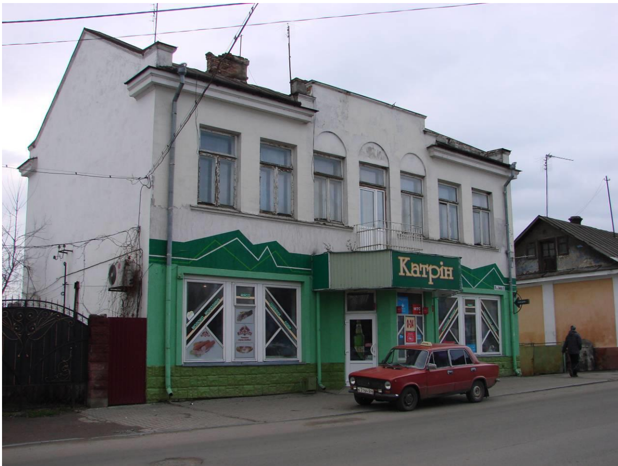
Фото 3.15. Житлово-торговий будинок, 20-30-і рр. XX ст., вул. Замкова, 18 (12)
