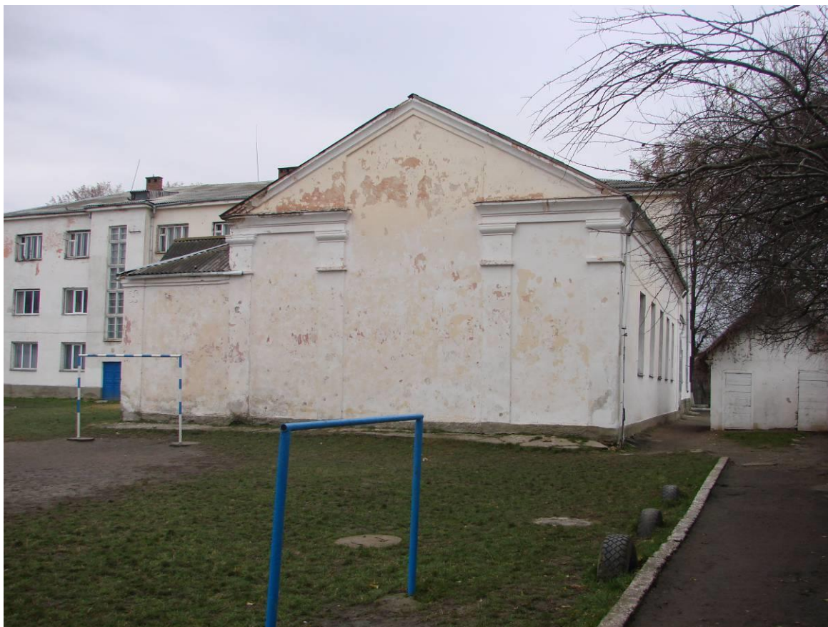
Фото 3.12. Школа, 20-30-і рр. ХХ ст., вул. Стара, 20. Будівля спортзалу. Загальний вигляд з півночі
