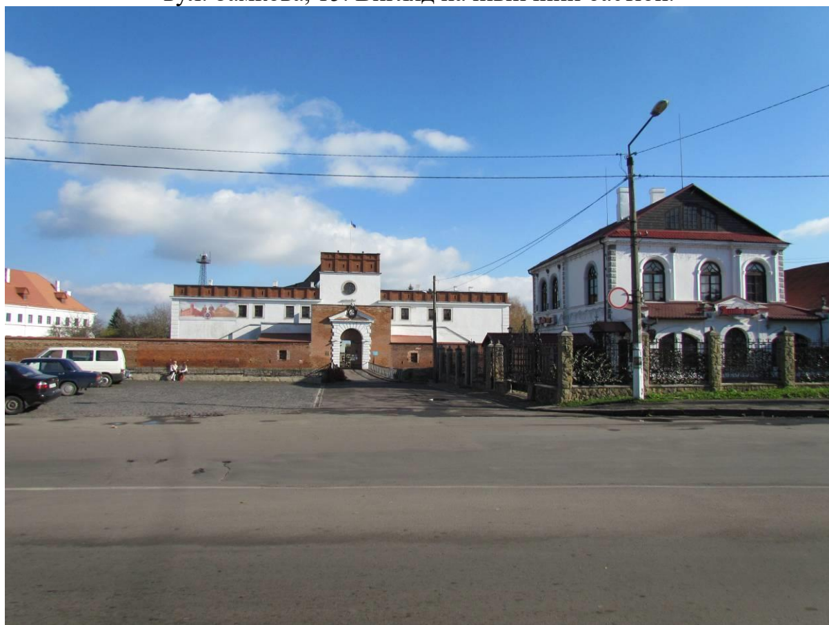
Фото 1.2. Оборонні мури та надбрамний корпус замку, XVI-XVII ст. вул. Замкова, 15. Вигляд з вул. Костянтина Острозького.
