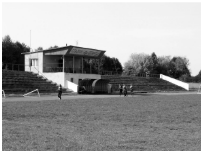
Прожовжується капітальний ремонт та реконструкції стадіону «Спартак», 2013 рік.
