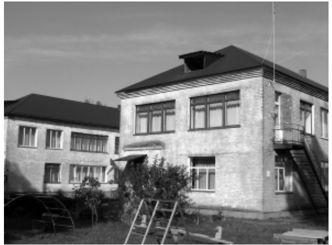
Реконструкція та покриття металопрофілем даху дитсадка №5, 2014 рік.
