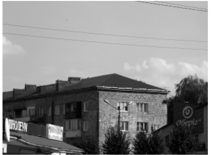
Дах будинку на вулиці Мирогощанській, 4 перекритий сучасними покрівельними матеріалами (металопрофілем), 2013 рік.
