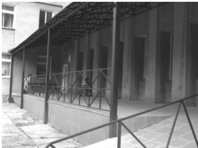
Капітальний ремонт ґанку адміністративного приміщення пологового будинку, 2015 рік.
