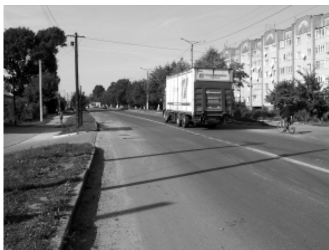
Вулиця Сурмичі після заміни аварійної водопровідної мережі з використанням поліетиленових труб, 2012 рік.
