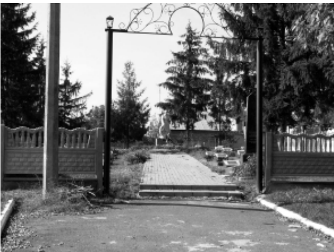
Ремонт огорожі та облаштування арки меморіального кладовища, 2013 рік.
