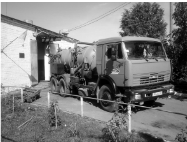
Вперше за 30 років було проведено очистку головної каналізаційно-насосної станції міста, 2015 рік.
