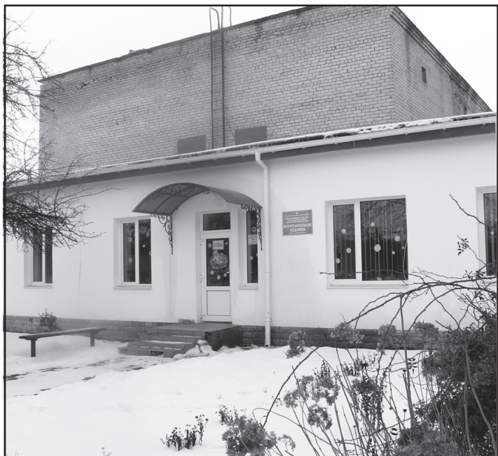
Капітально відремонтоване приміщення туберкульозного відділення
