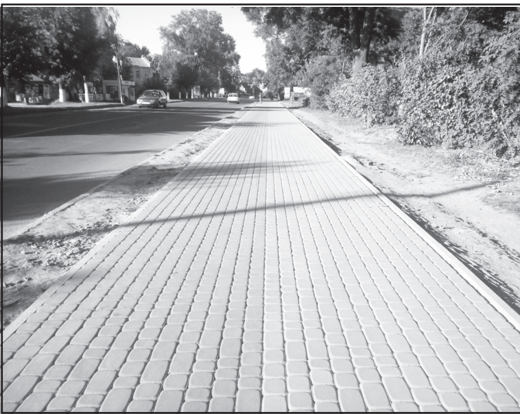
Реконструкція тротуару на вулиці Грушевського
