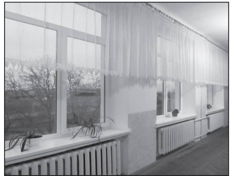
Відремонтовано коридор гімназії №1 м.Дубна на 1-му поверсі із заміною вікон на металопластикові
