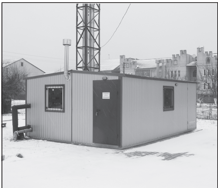
Побудовано модульну котельню для НВК «Школа-сад»
