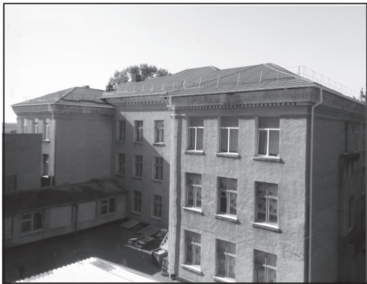
Капітально відремонтовано дах ЗОШ №7
