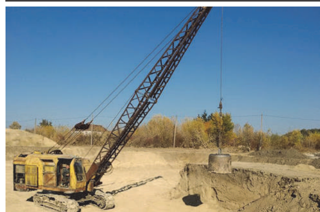
Розпочато будівництво дитячого садочка
