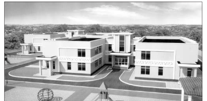
Будівництво ДНЗ (проєкт).
