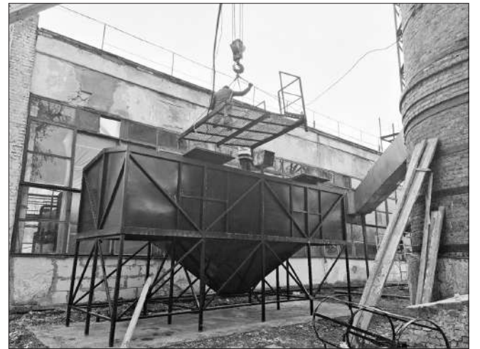
Модернізація котельні на вул. Острозького, 23.
