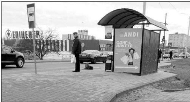
Ремонт посадкового майданчика зупинки Сирзавод.
