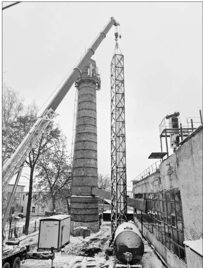
Модернізація котельні на вул. Острозького, 23
