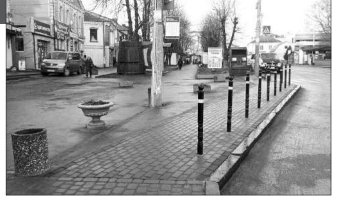
Поточний ремонт тротуару з влаштуванням пішохідного переходу на майдані Незалежності.
