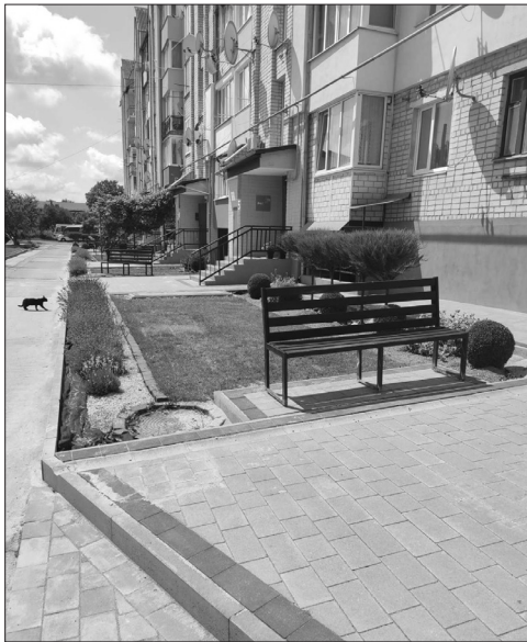
Поточний ремонт прибудинкової території житлового будинку на вулиці Мирогощанська, 69
