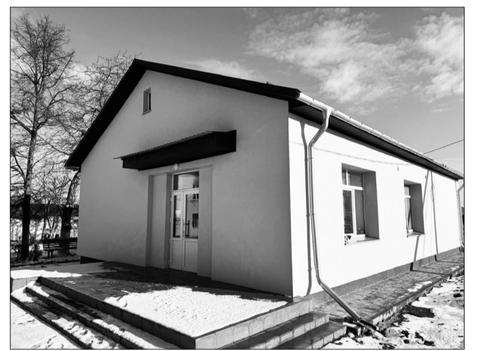
Капітально відремонтоване приміщення патологоанатомічного відділення
