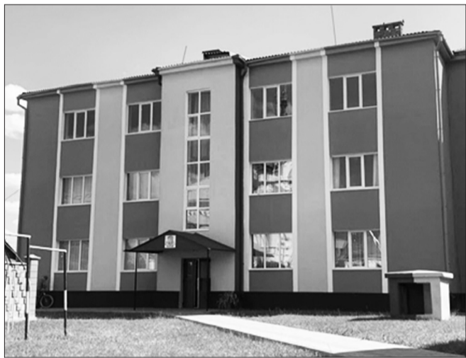
Оновлений фасад будівлі Дубенського ліцею №3
